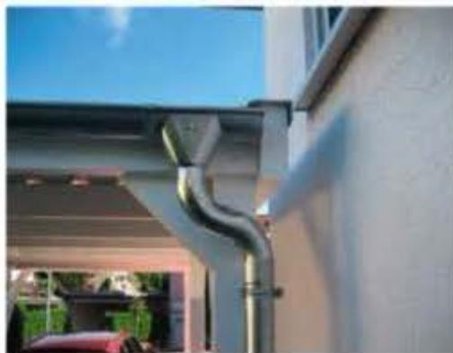
**ENDARBEITEN:** Abschließend werden die Überlappungen mit Silikon oder einem Dichtband versehen. Zudem empfiehlt sich die Montage einer Dachrinne.
