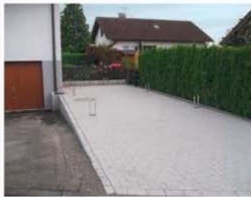
**UNTERGRUND:** Der Carportboden sollte das Versickern von Wasser zulassen oder ein leichtes Gefälle aufweisen. **VERANKERUNG:** Die Carportpfosten werden mit H-Ankern gesichert. Das Einbetonieren erledigt man am besten einen Tag im Voraus.
