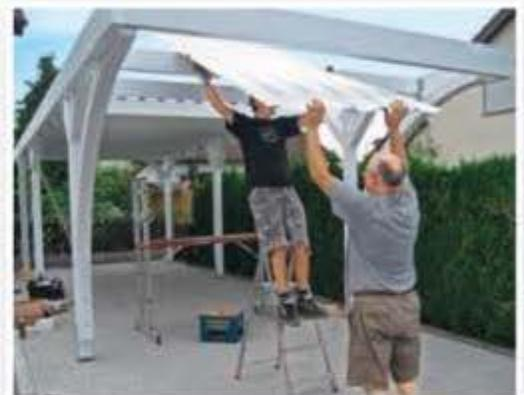
**DACHMONTAGE:** Bevor die Dacheindeckung mit Trapezbahnen fixiert wird, sollten alle Platten ausgelegt werden. So ist sichergestellt, dass neben den seitlichen Überständen auch die Überlappungen gleichmäßig und korrekt ausgerichtet sind.
