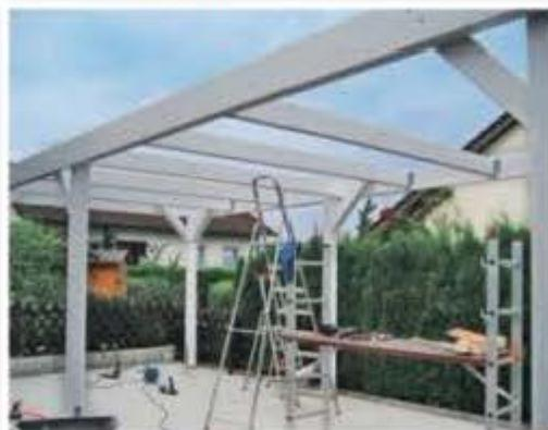
**SPARREN:** Für weitere Stabilität sorgen die Sparren, die im Anschluss an den Sattelbalken befestigt werden und das Dach fast vervollständigen. Das rechte Maß der Sparren ist von besonderer Bedeutung, denn die kleinste Abweichung gefährdet das Projekt.
