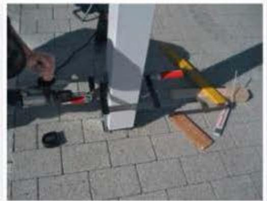
**GRUNDPFOSTEN:** Ist der Beton ausgehärtet, setzt man die Pfosten in die H-Anker ein. Dabei sind die Pfosten auszurichten und mit gleichen Abständen innerhalb der Anker zu platzieren. Dann werden sie vorgebohrt und verschraubt.
