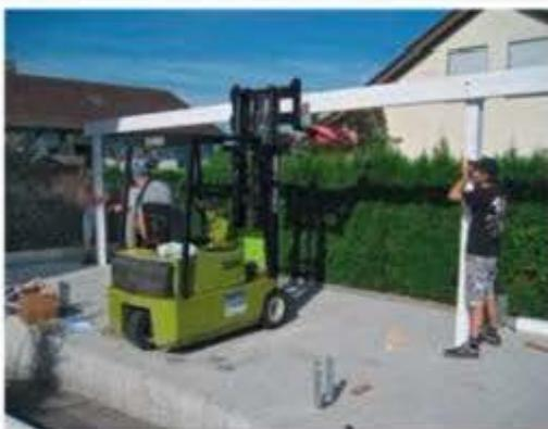
**SATTELBAKKEN:** Durch das Aufstellen der Pfosten nimmt der Carport langsam Form an. Nun geht es an das Errichten des Daches, welches mit dem Auflegen der Sattelbalken beginnt. Halt bekommt die Konstruktion durch Schlossschrauben.
